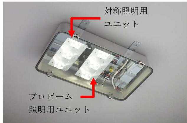
図 4.3.1.1-3 対称照明用とプロビーム照明用のユニットを内蔵した器具の例
